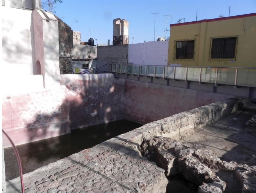
Estado actual del aljibe del acueducto del fraile Francisco de Tembleque
